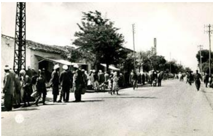
Route de la Gare
