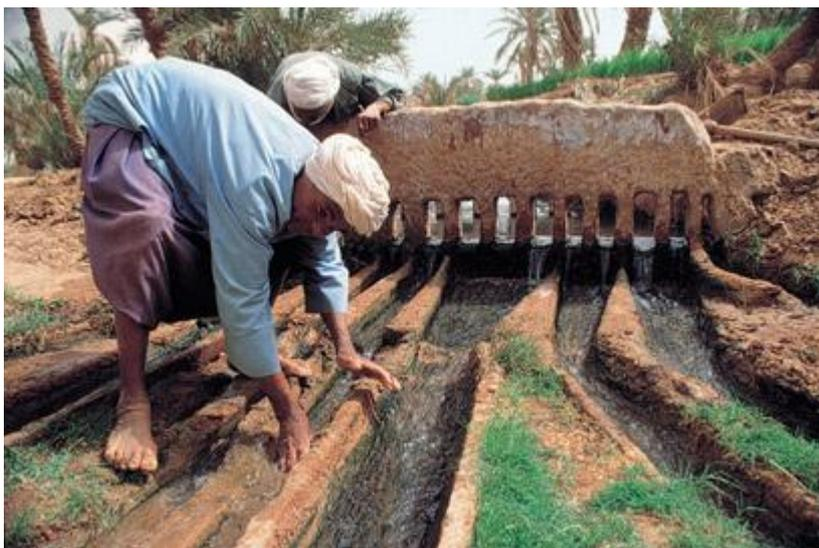
Le système des foggaras permet de répartir l'eau à travers l'oasis
