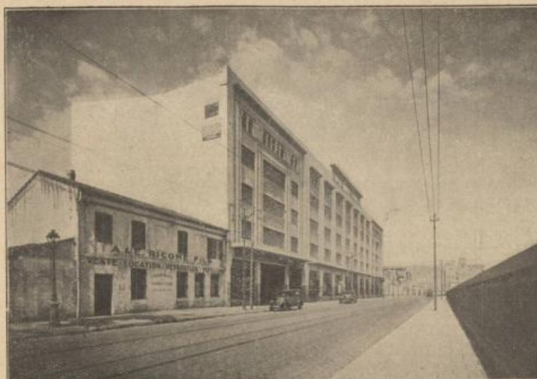
Garage Vincon, à Alger Vue extérieure (Bétons armés Hennebique) (Ph. de Louvencourt, Alger)
