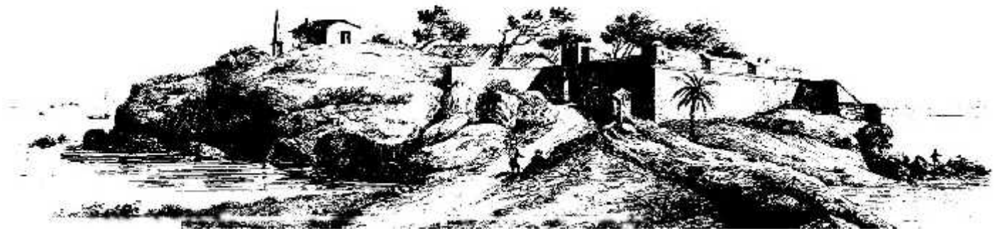
Le fort DUQUESNE à DJIDJELLI
