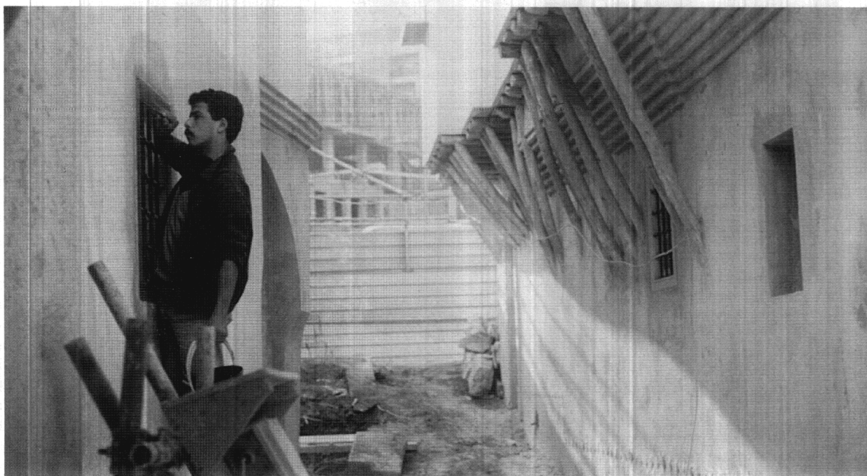
BASTION 23: ENTRETIEN DES CORNICHES EN TUF DES FENETRES.
