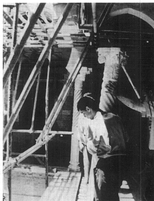
RESTAURATION DES COLONNES EN MARBRE
