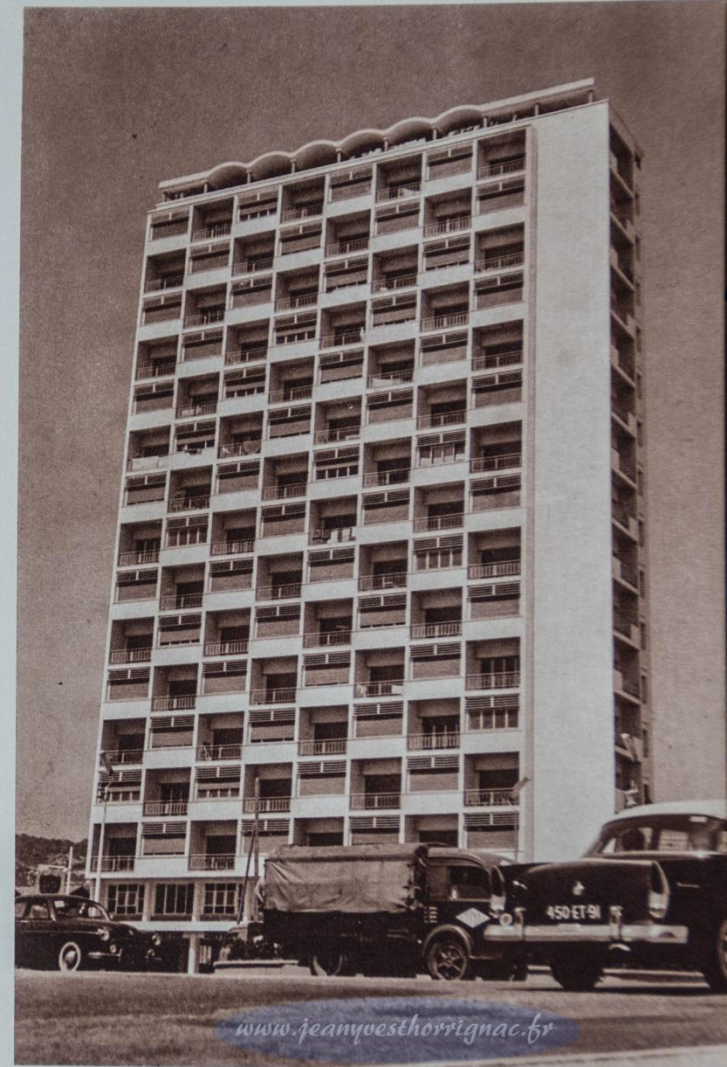
Immeuble « Pernod », Carrefour Polignac
