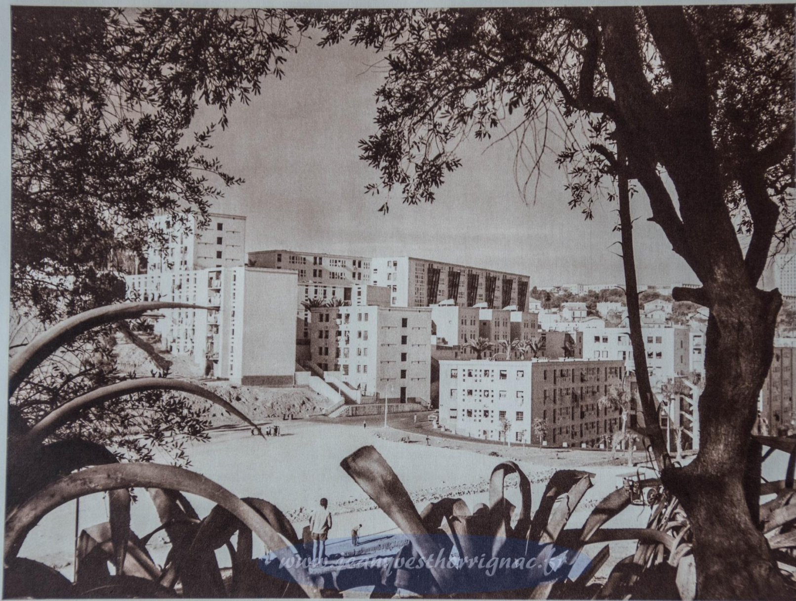
Diar-el-Mahçoul : Partie Sud de la cité (immeubles type « simple confort »), vue du Bois des Arcades.
