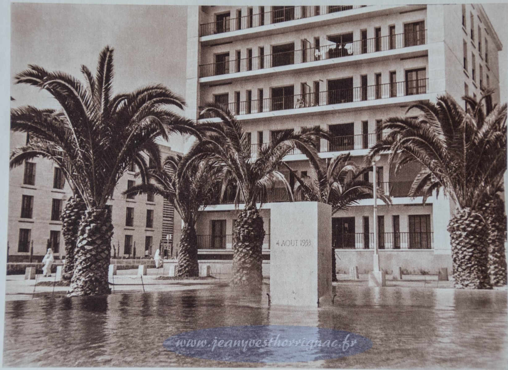
Diar-es-Saâda : Place des Palmiers. Bassin de la première pierre - 4 Août 1953.
