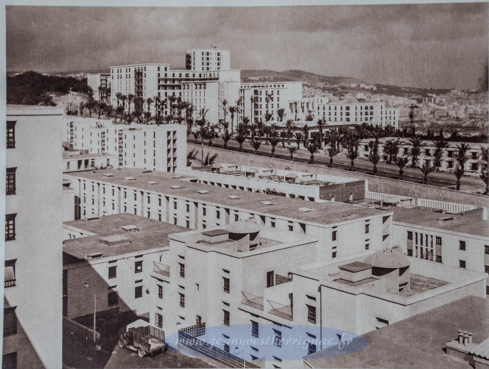
Diar-el-Mahçoul : La cité « confort normal » vue de la cité « simple confort ».
